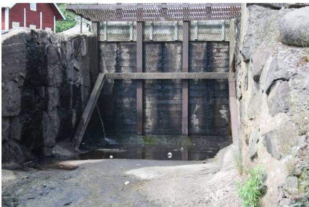
Bild 5. Flodutskovet (f) (som svårigen kan öppnas) där en slitsränna enligt alternativ 2 kan placeras.
