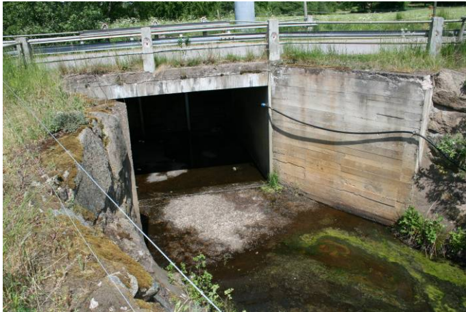
Bild 1. Torrfårans övre del vid genomföring under väg. I förslag 1A bibehåller detta utskov sin funktion medan förslag 1B innebär att det istället utnyttjas för fiskväg.
