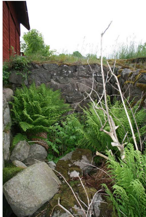
Bild 8. Grundmur där håltagning erfordras enligt alternativ 3
