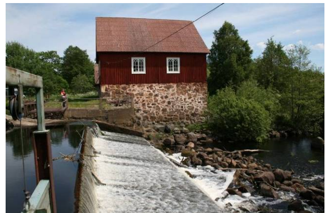
Bild 6. I förgrunden syns dammens skibord och i bakgrunden den grundmur invid flodutskovet som hamnar i anslutning till den i alternativ 2 föreslagna slitsrännan.
